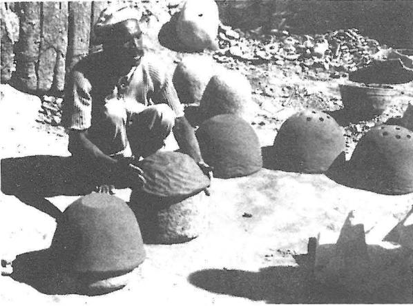
Photo 7 - Façonnage sur une forme d'argile. Le potier met en forme une galette d'argile sur un dôme. L'atelier comporte plusieurs dômes de tailles différentes suivant le module des vases désirés (région de Zagora).
